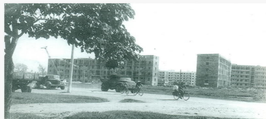
Đào tạo nhân lực, sửa chữa và xây mới các công trình sau chiến tranh trên địa bàn cũng như toàn quốc tạo tiền đề cho sự phát triển kinh tế
